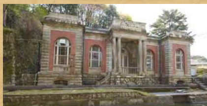
旧御所水道ポンプ室
