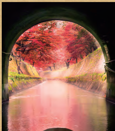
第一トンネル出口
